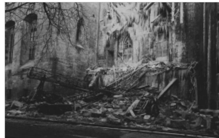
Einsturzstelle beim Schlossbrand am 22. Dezember 1931. Rechts die zerstörte Untertürkheimer Leiter
